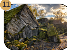
Ruine der Hindenburgbrücke
